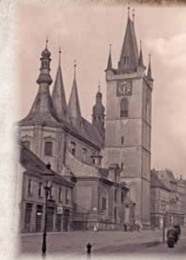
Litoměřice, Kostel Všech svatých, severní fasáda se zvonící, pohled z Dlouhé ulice, foto před rokem 1918 (Ústav dějin umění AV ČR, sbírka Staré fotografie, původem z Centrální komise pro památkovou péči)
