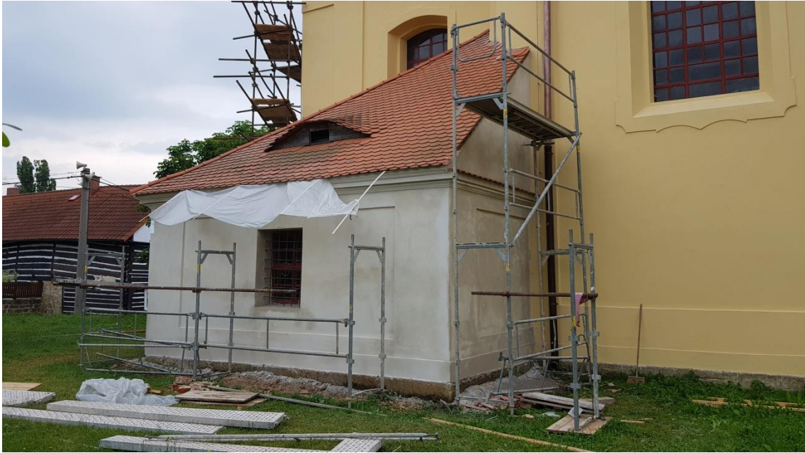
Obnovená fasáda byla přestukována a natřena.
