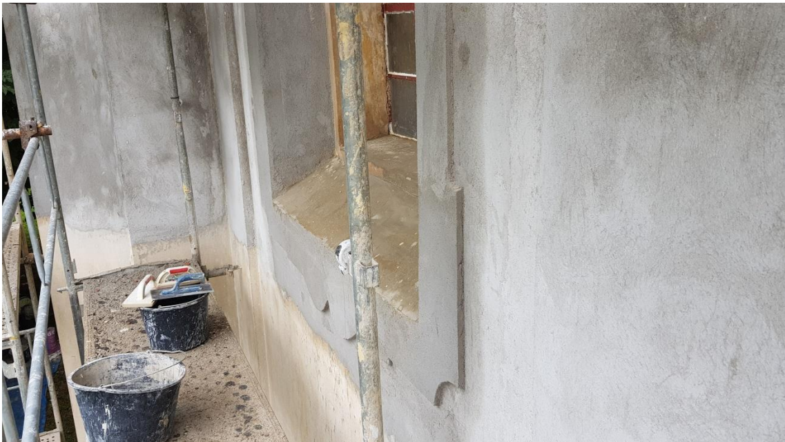
Obnoveny byly všechny původní všechny původní architektonické prvky (římsy, pilastry, šambrány atp.)
