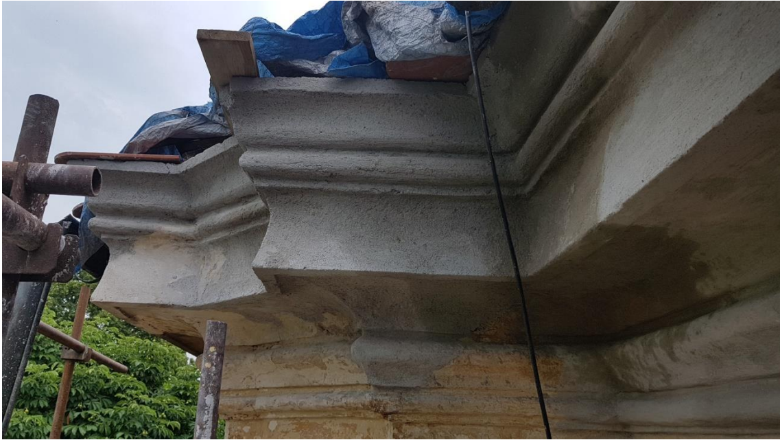
Poškozená a lokálně chybějící korunní římsa byla opravena do původní profilace.
