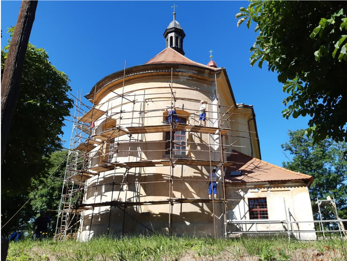
Pohled na východní stranu kostela sv. Jiří ve Chlumu v průběhu realizace prací etapy roku 2020. Nesoudržné části fasády byly odstraněny, fasáda byla omyta a byly obnoveny profilace původních architektonických prvků.
