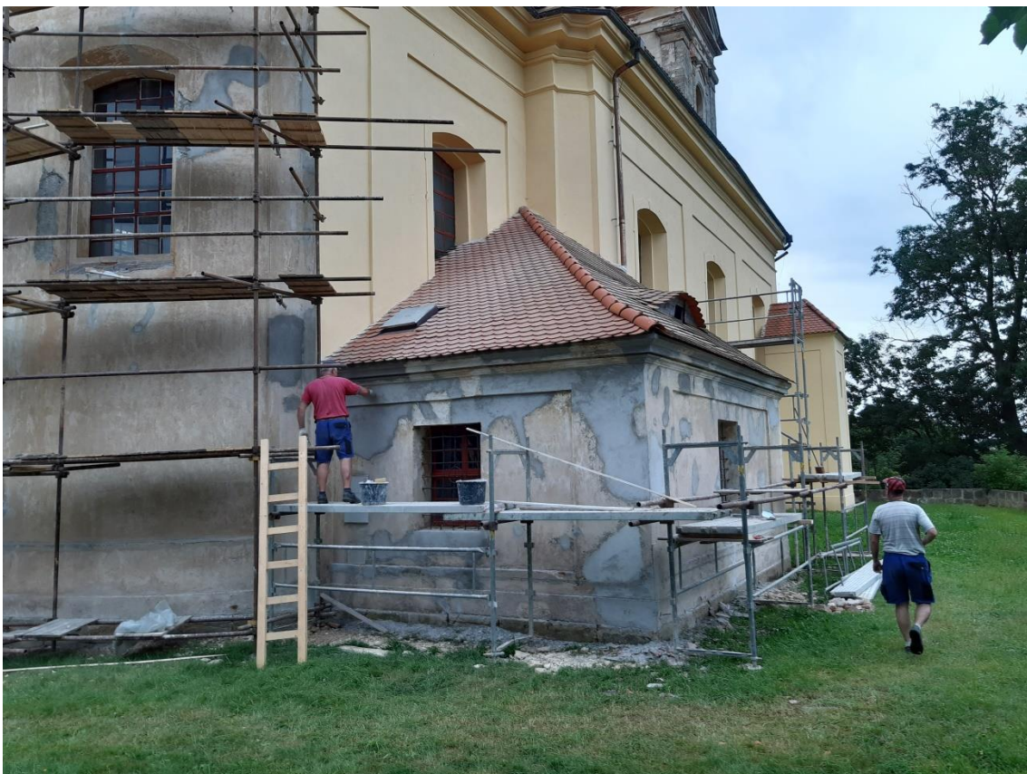
Pohled na východní stranu kostela sv. Jiří ve Chlumu v průběhu realizace prací etapy roku 2020. Nesoudržné části fasády byly odstraněny, fasáda byla omyta a byly obnoveny profilace původních architektonických prvků.
