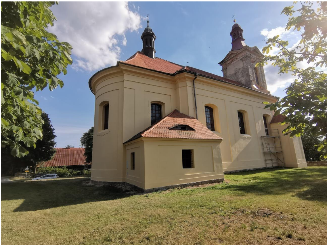
Pohled na severovýchodní nároží kostela sv. Jiří ve Chlumu po dokončení prací etapy roku 2020.
